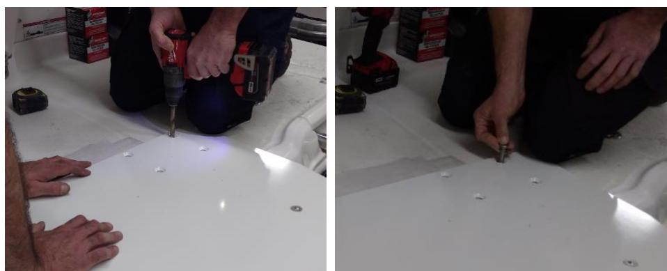
La plaque d'extension (20) est ainsi maintenue à sa position finale. Il est alors possible de percer les autres trous nécessaires. **Attention de percer seulement les trous nécessaires en fonction du mode de fixation choisi.**
