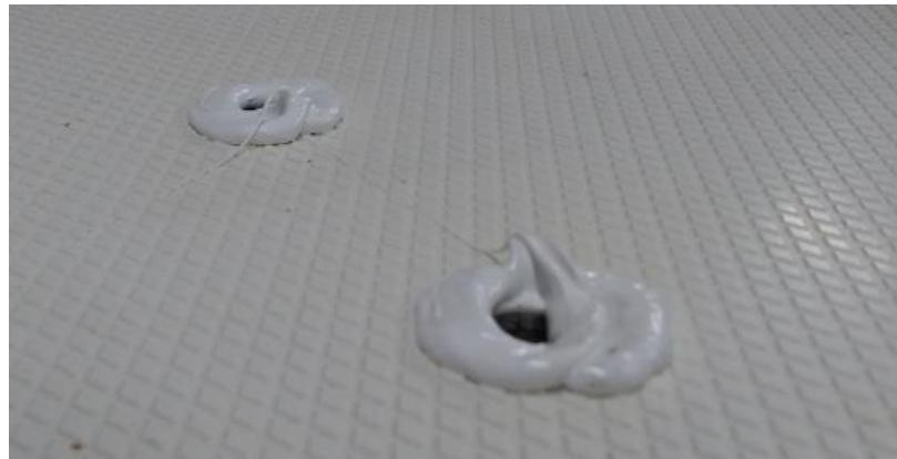
Appliquer un cordon de scellant entre les trous ainsi que sur la surface de la plateforme de baignade qui sera en contact avec la plaque d'extension.
